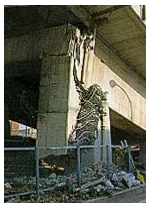
写真 1-1 鉄筋コンクリート橋脚の地震時の被害例
