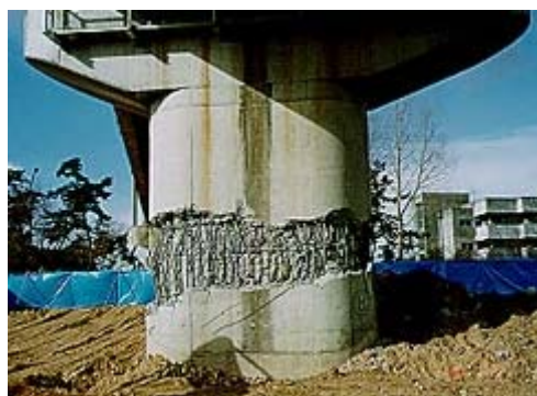
写真 1-1 鉄筋コンクリート橋脚の地震時の被害例
