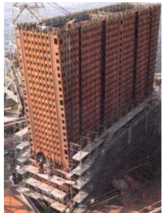
建設中の類似構造
