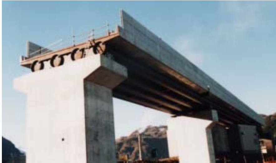
図 1.3 完成した鋼管桁
