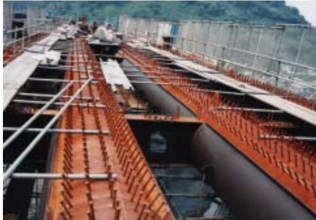
図 1.1 建設中の鋼管桁（上面）
