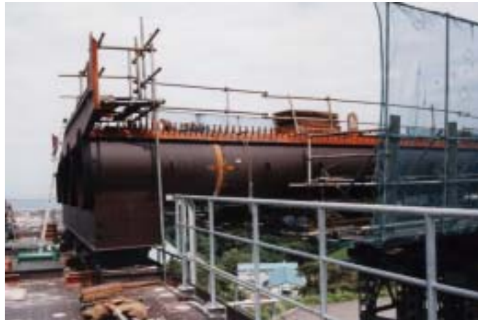
図 1.2 建設中の鋼管桁（桁端部側面）
