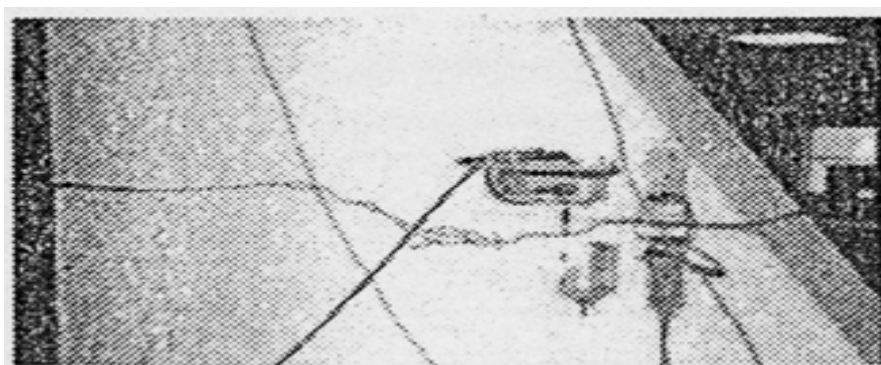
3回目加振時のひび割れ状態
