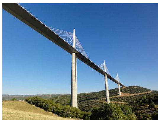
写真 2.4 ミヨ一高架橋
