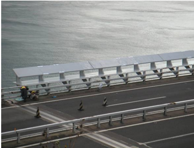
図 1.3 風による振動を抑制するためのダブルフラップ
