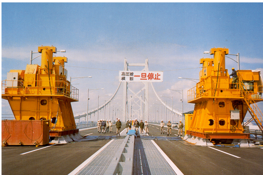
図 7.8 実橋振動実験(南備讃瀬戸大橋)
