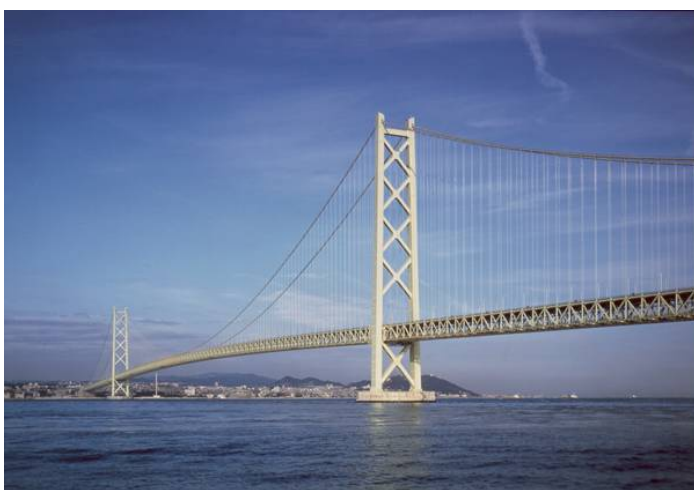
図 1.5 耐風工学の粋を集めた明石海峡大橋(本州四国連絡橋公団提供)
