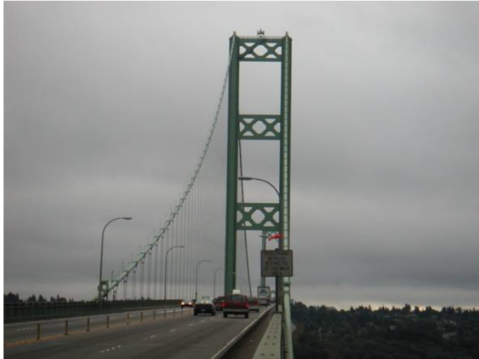
図 1.1 再建されたタコマナロウズ橋(旧橋は風による振動で 1940 年に落橋した)
